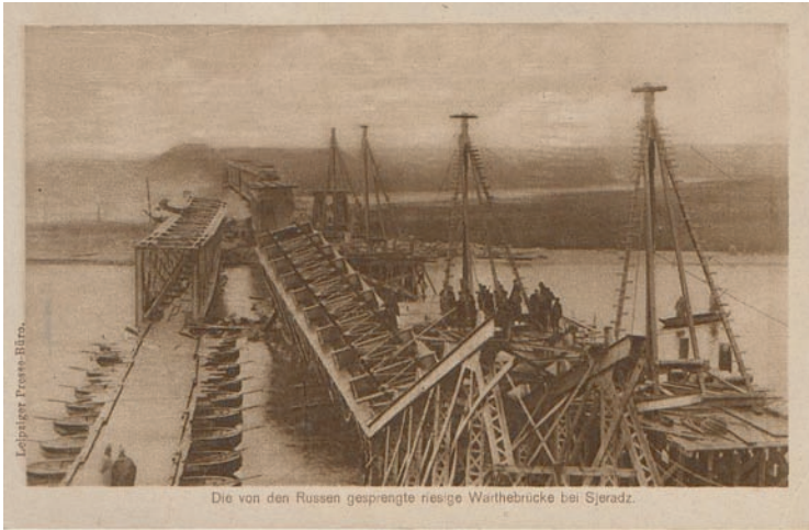
Zniszczony przez Rosjan most kolejowy na Warcie (Zbiory własne).
