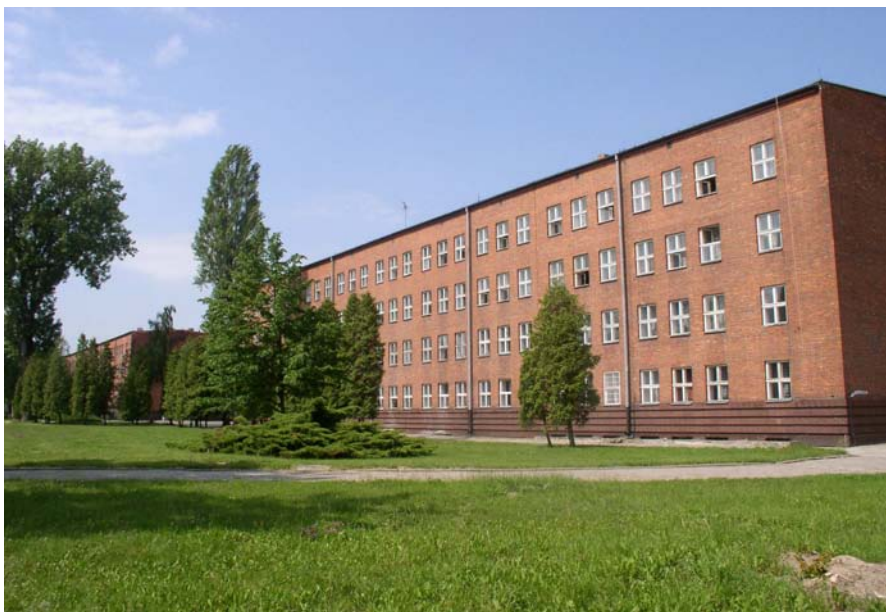
Sieradz 2005; bloki koszarowe wybudowane w latach 1933-1935
